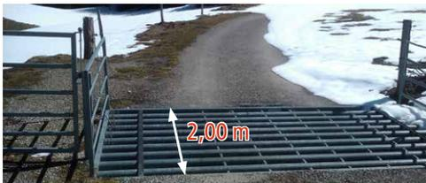
Soit 1 passage canadien posé entre une clôture extérieure et une clôture intérieure et dont la profondeur est de 2 mètres à minima.
